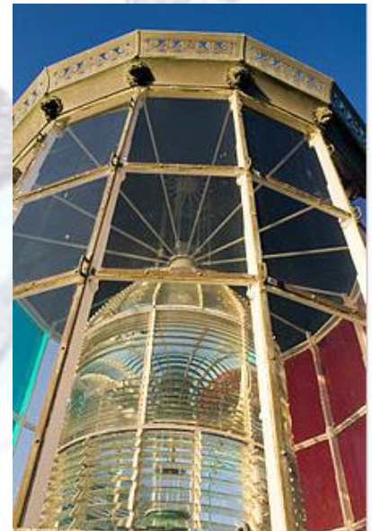
Lentille de Fresnel du phare de Cordouan, la première lentille qui y fut installée fut démontée et remplacée par une lentille de Fresnel du premier ordre en 1856.
